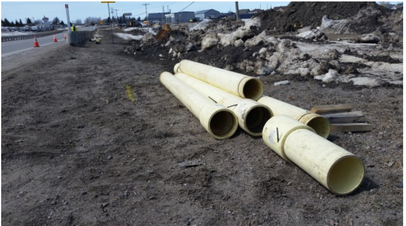
Un chantier d'aqueduc dans la région de Montréal Photo : Radio-Canada/Meghann Dionne
